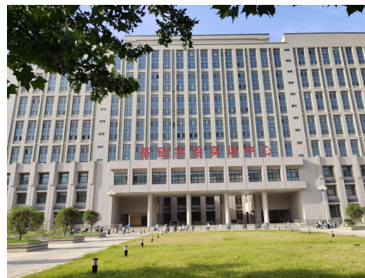
本科生实验楼
