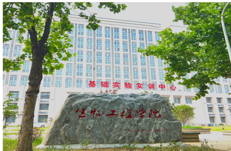
生物工程学院教学实验楼
